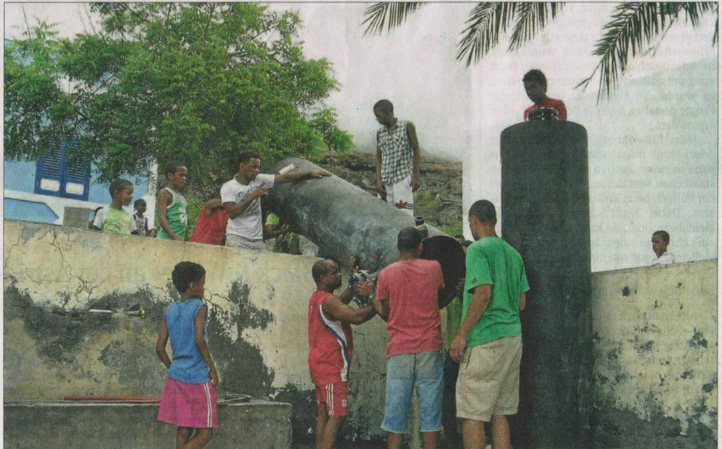
Auf den Kapverden kann die Fluorid-Filteranlage aus Deutschland installiert werden.
